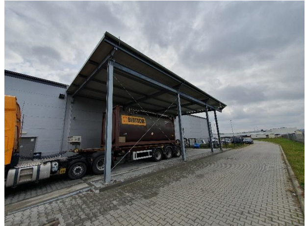
Wiata rozładunkowa przy osi A /10-13
