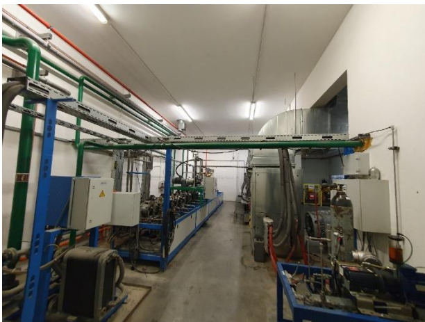
Pomieszczenie P.0.02 – pompownia izopentanu
