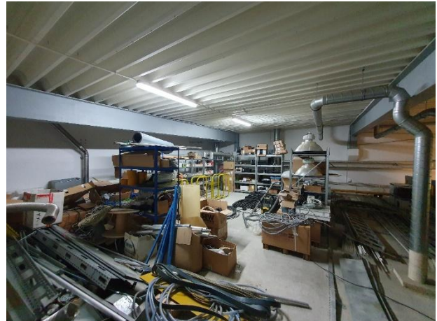
Strop nad pomieszczeniami P.0.07 i P.0.10
