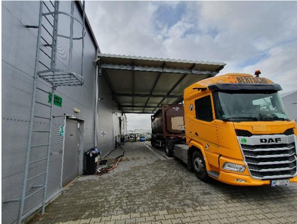
Wiata rozładunkowa przy osi A /10-13
