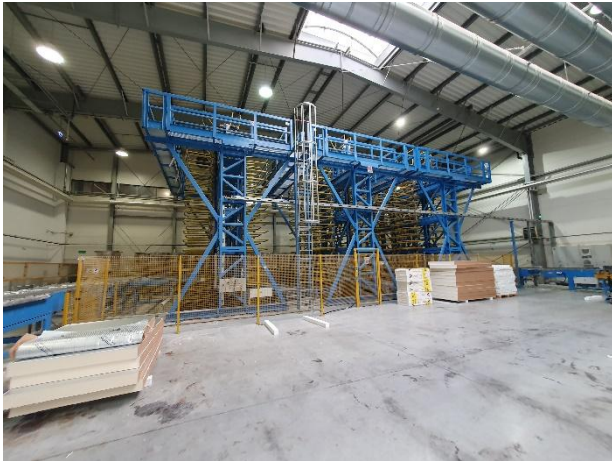
Nawa produkcyjna – linia do chłodzenia płyt
