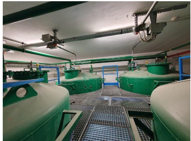
Pomieszczenie zbiorników P.0.06 – podest techniczny + strop
