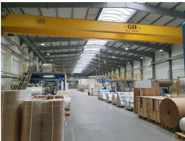
Nawa produkcyjna – widok w kierunku południowym
