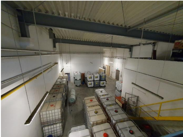
Pomieszczenie P.0.05 + oddzielenie pomieszczenia zbiorników P.0.06
