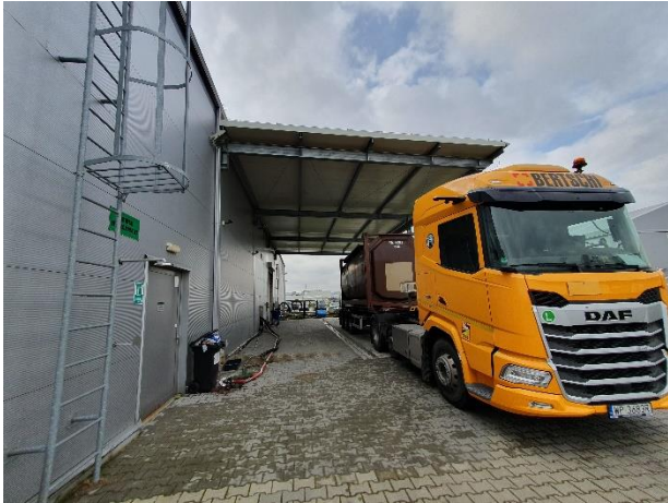
Wiata rozładunkowa przy osi A /10-13
