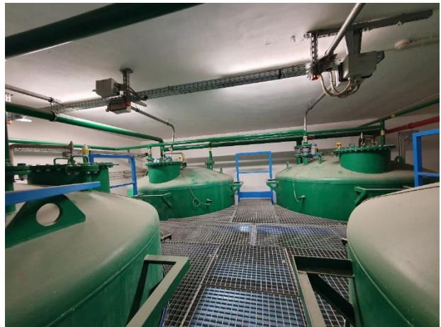
Pomieszczenie zbiorników P.0.06 – podest techniczny + strop
