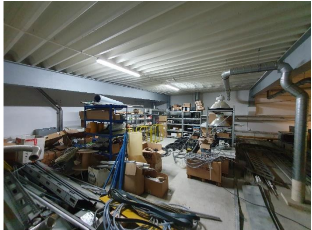
Strop nad pomieszczeniami P.0.07 i P.0.10
