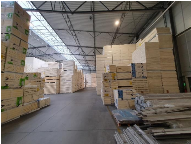
Magazyn – składowanie + konstrukcja
