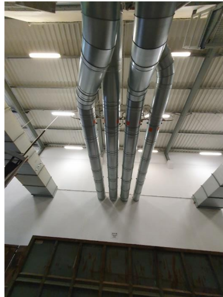
Pomieszczenie wentylatorów P.0.08 – kanały przy osi 19 i 20 (nie naniesione na projekcie technologii)
