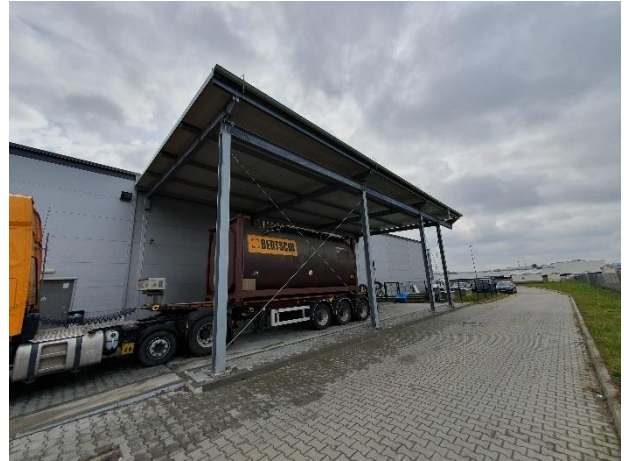
Wiata rozładunkowa przy osi A /10-13
